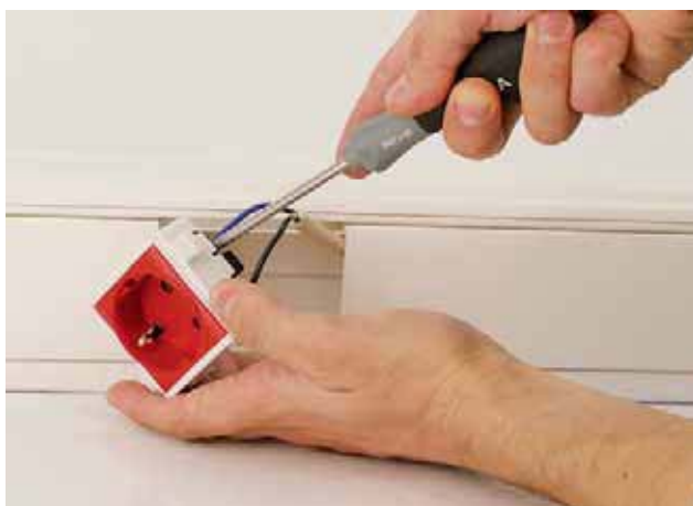
3. Подсоедините провода к розетке
