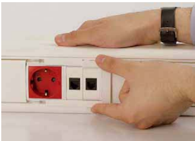
5. Установите рамки F00001 защелкиванием
