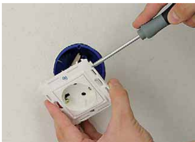
3. Подсоедините провода к розетке
