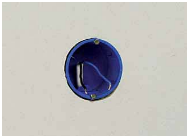
1. Установите коробку в отверстие в стене
